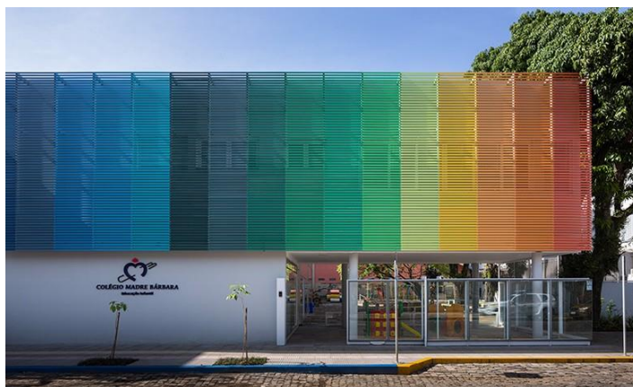
Figura 10 - Exemplo de brise colorido em fachada
