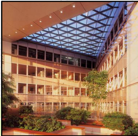
Figura 4.3- torre do Commerzbank.
