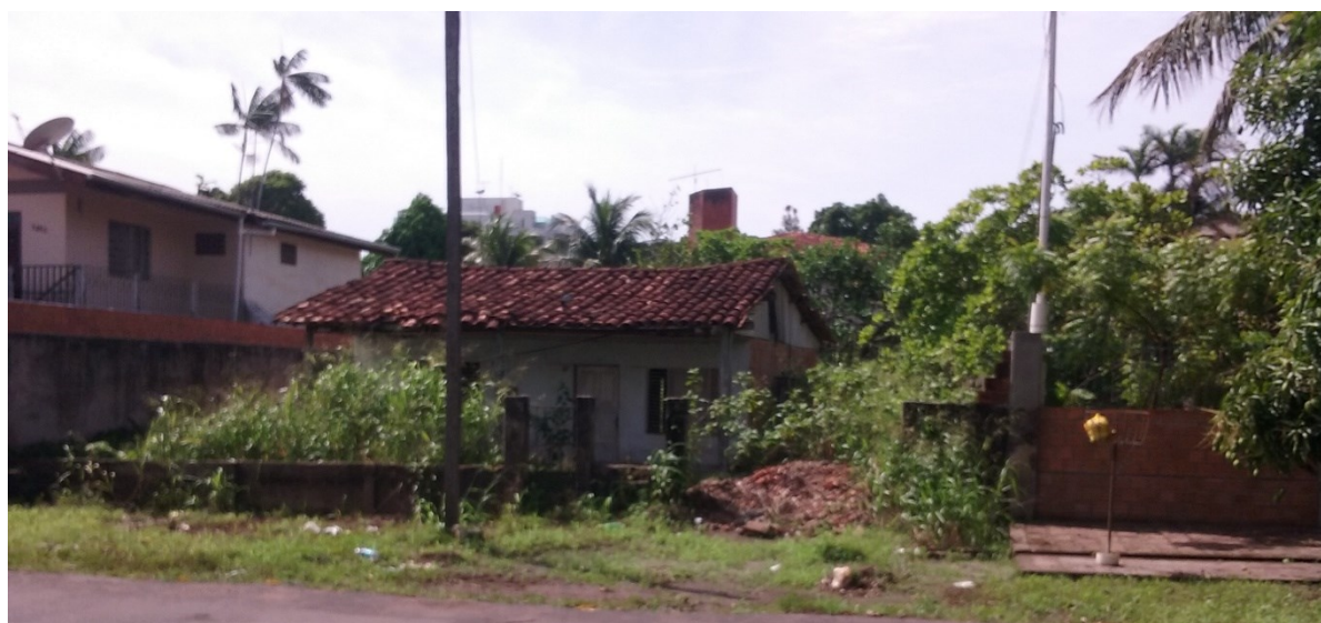
Figura 11 - Edificação abandonada na Av. Duque de Caxias, janeiro de 2018
