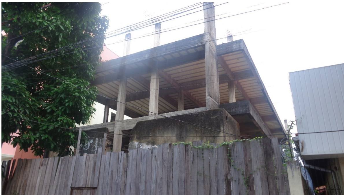
Figura 9 - Edifício abandonado na Avenida FAB.
