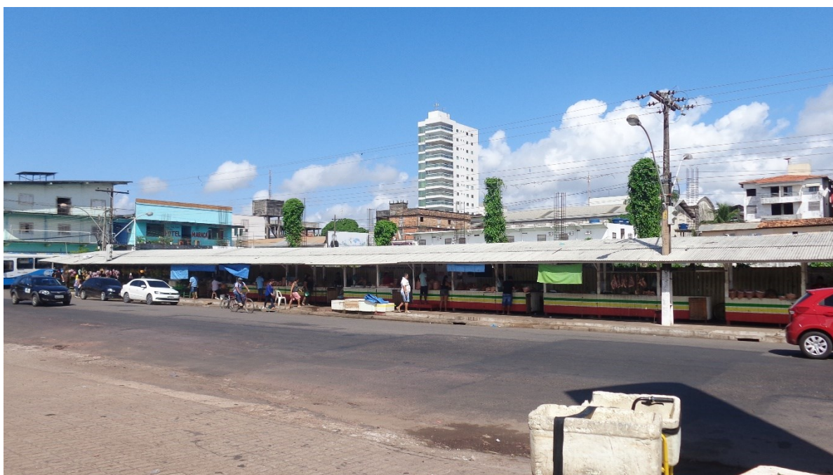
Figura 13 - Feira do caranguejo, improvisada junto ao tapume das obras do Shopping Popular
