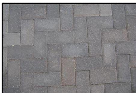
Fig. 59 - Piso Intertravado “tipo tijolo”
