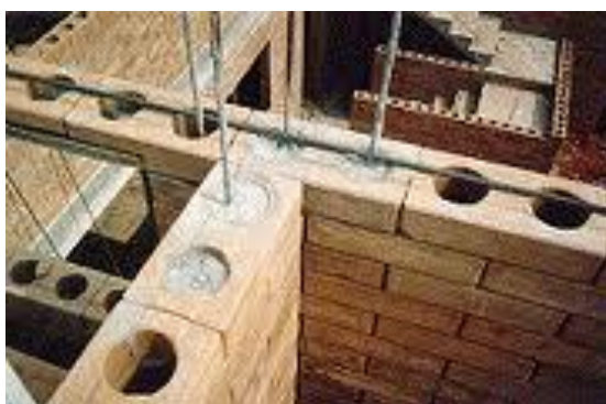
Figura 17 – Vista de pilares de encontro com as paredes Fonte: www.comosereformaumplaneta.wordpress.com
