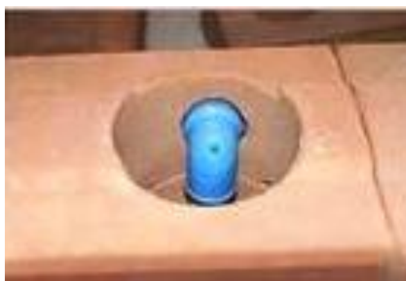
Figura 22 – Colocação de tubulações hidráulicas Fonte: SAHARA – 2001
