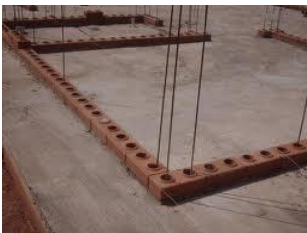
Figura 20 – Colocação das primeiras fiadas de tijolos Fonte: goiania.olx.com.br
