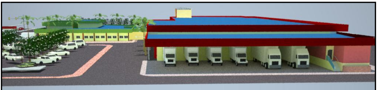
Imagem 20: Fachada Nordeste Fonte: acervo grupo. Novembro/2010
