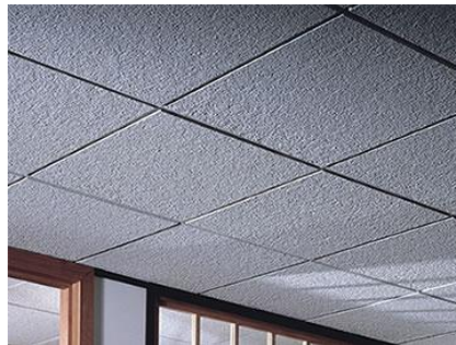
Figura 04: Forro em Gesso Acartonado
