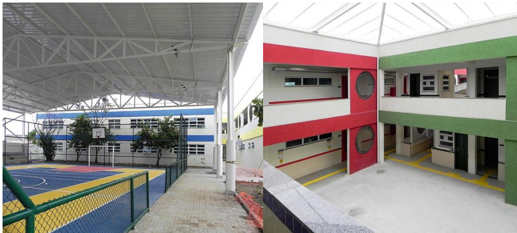
Figura 7 - Quadra com cobertura branca/ pátio interno com luz natural
