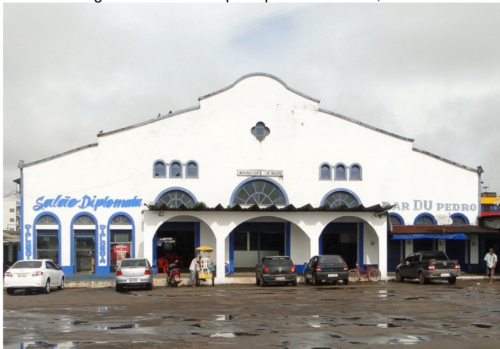
Figura 9 – Fachada principal do Mercado, 2015.
