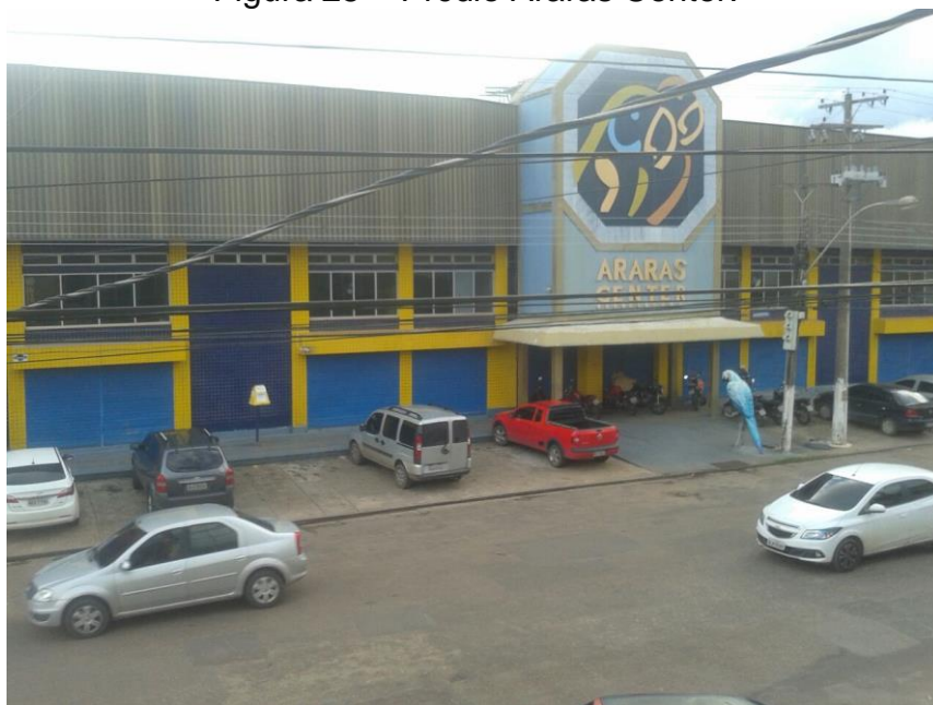
Figura 25 – Prédio Araras Center.
