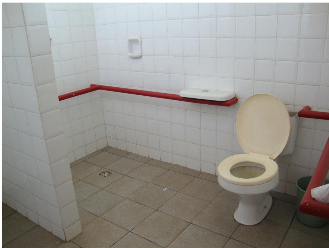
Figura 52 – Banheiro Adaptado – Bacia Sanitária e Box
