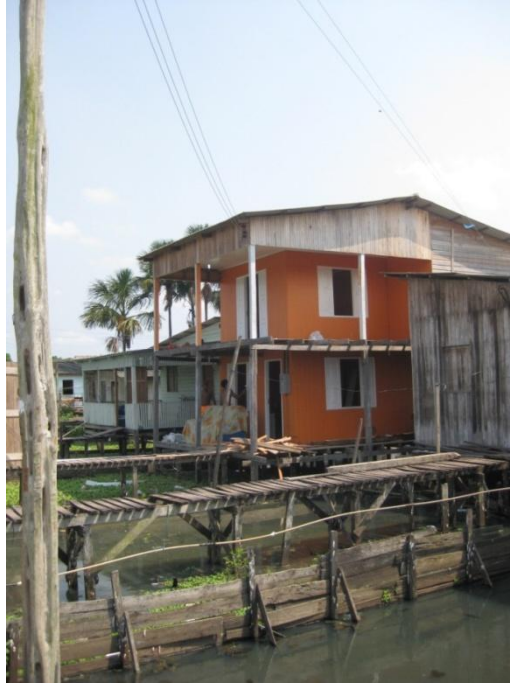
Figura 31: Edificação em dois pavimentos.
