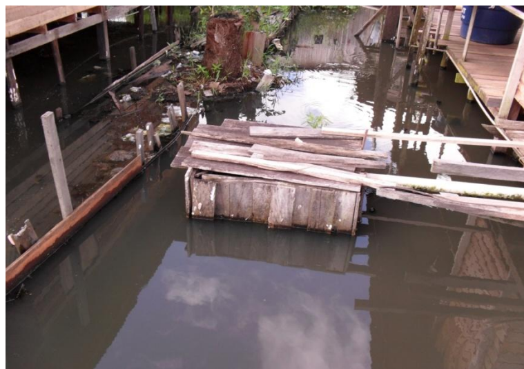
Figura 36: Caixa coletora de esgoto na água (fossa negra).
