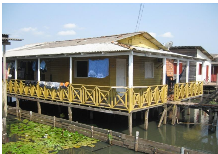
Figura 59: Varanda circulando residência e detalhe de guarda corpo bem elaborado.
