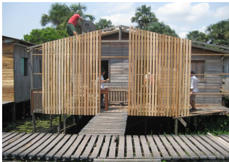
Figura 40: Construção de uma residência.
