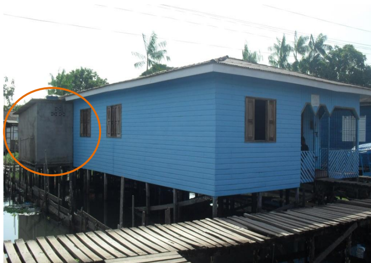
Figura 52: Banheiro em Alvenaria.
