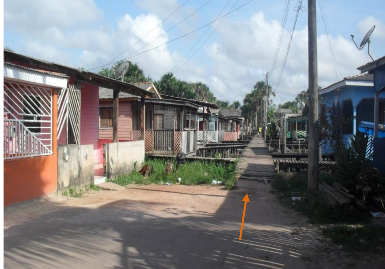
Figura 38: Acesso à ponte.
