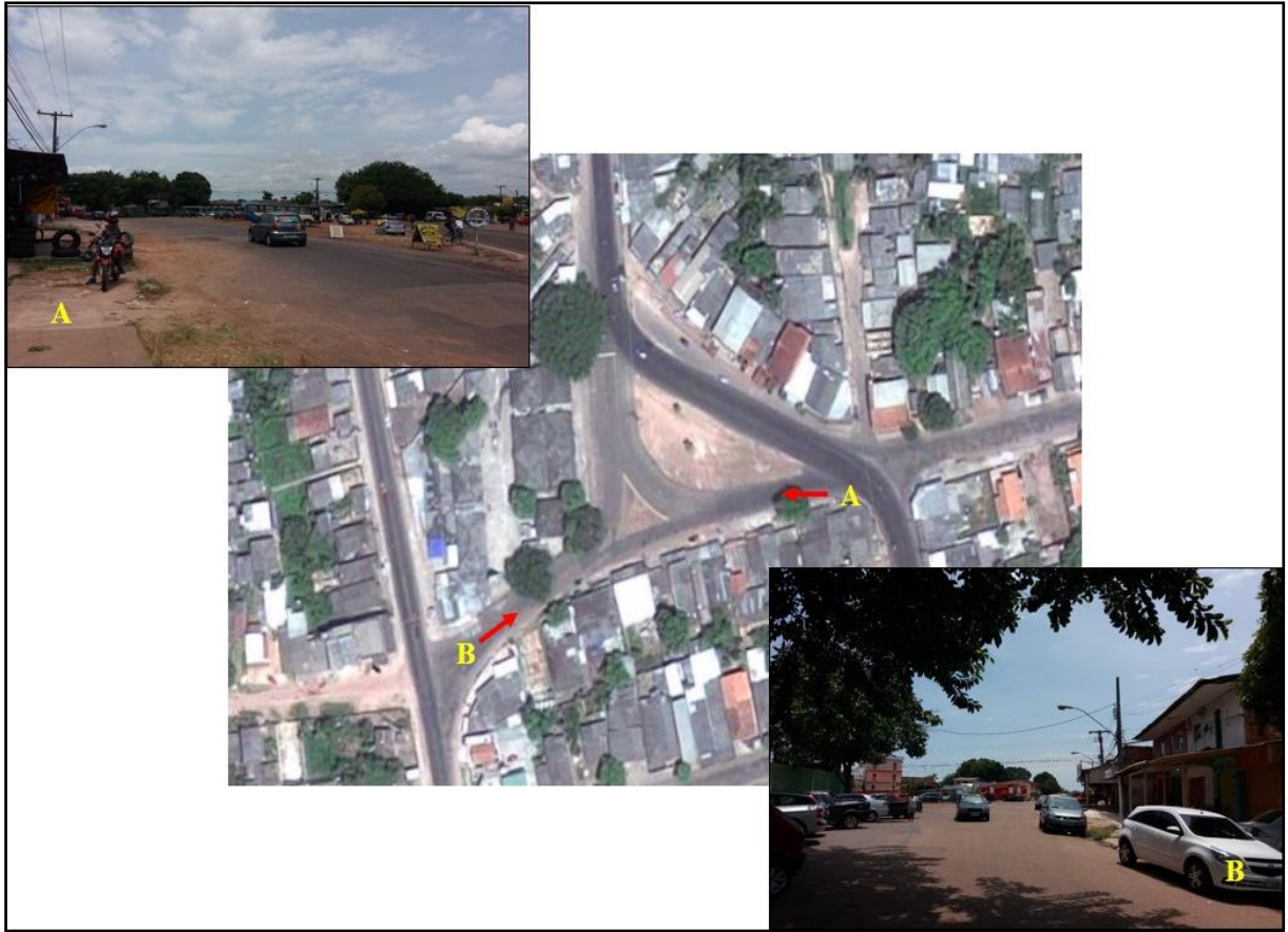
Figura 35 - Via coletora: Avenida Acre (Arruamento).
