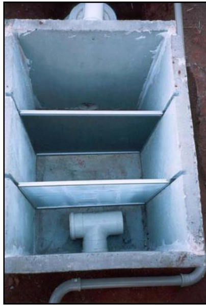
Figura 10 - Filtro moldado in loco Fonte: CAMPUS, 2004, p.33
