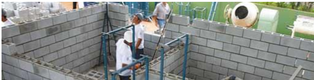
Figura 03: Execução de habitações com bloco estrutural Fonte: www.construcaomercado.pini.com.br
