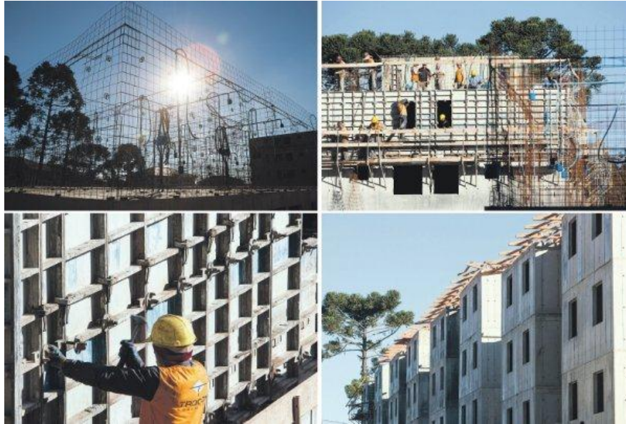
Figura 08: Execução de habitações com o uso dos pré-fabricados.
