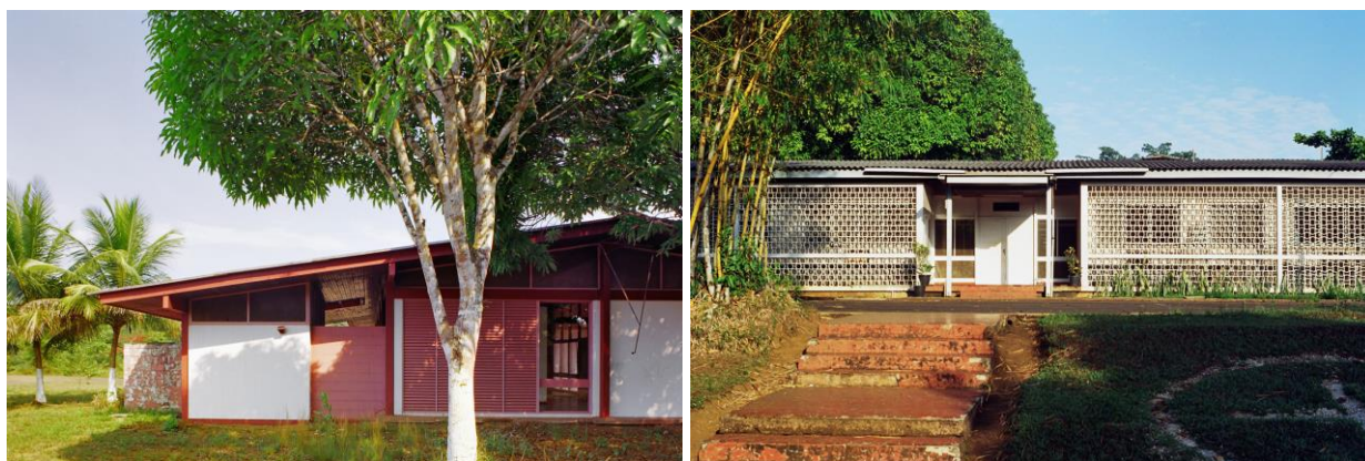
Figura 50 – Residências na Vila de Serra do Navio
