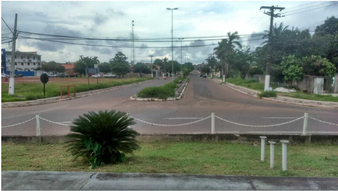
Fonte: Relatório fotográfico - SEINF
