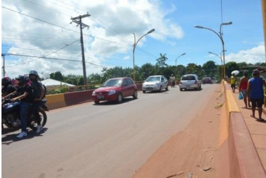
Figura 4.5: Ponte da Rodovia Salvador Diniz (AP-010). Fonte: Autora, 2013.
