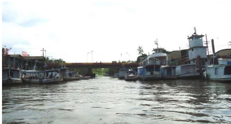
Figura 4.12: Ponte que liga Macapá e Santana sobre o Igarapé da Fortaleza junto ao portuário. Fonte: Autora, 2013.
