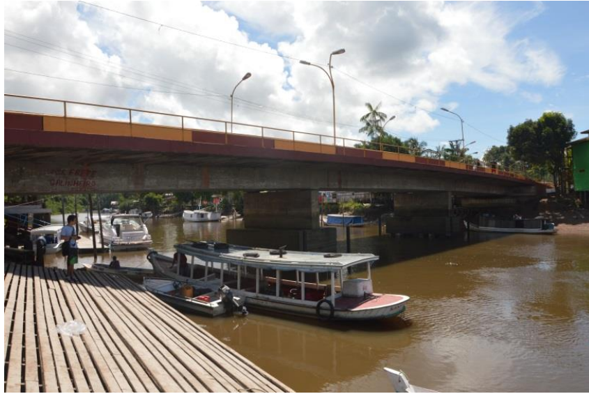
Figura I: Rampa Portuária do Igarapé da fortaleza. Fonte: Fernanda Amaro, 2013.
