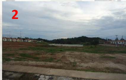
Área destinada a construção de praça.
