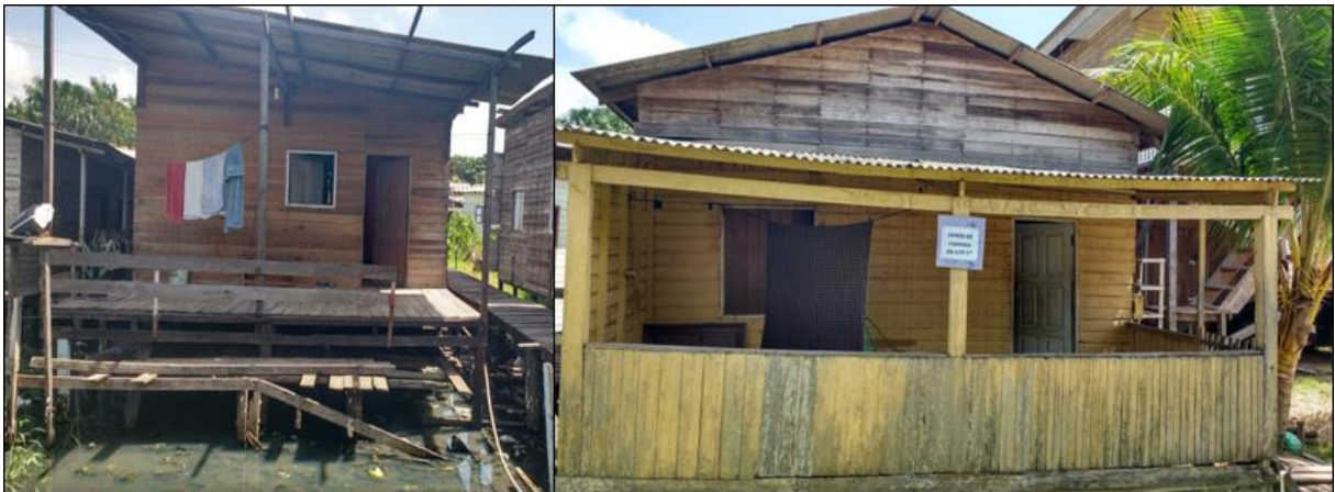
Figura 9 - Residências palafíticas na ressaca do Pacoval. Figura A à esquerda e figura B à direita.
