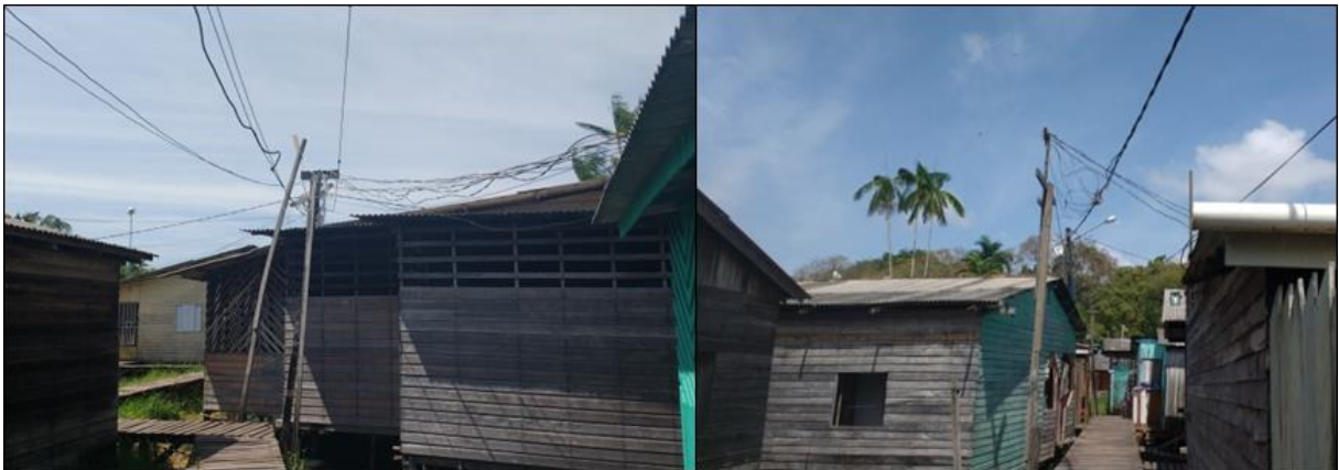
Figura 11 - Distribuição de energia elétrica na ressaca do Pacoval. Figura A à esquerda e figura B à direita.
