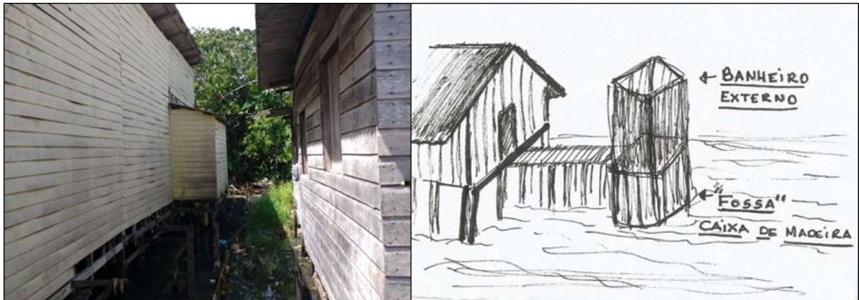
Figura 13 - Descarte do esgoto sanitário na ressaca do Pacoval. Figura A à esquerda e figura B à direita.
