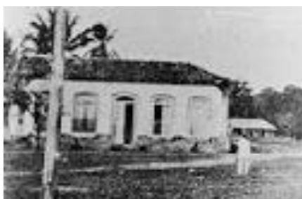
Figura 63 - Casa particular onde funcionava a Biblioteca.
