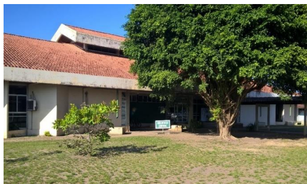
Figura 80 - Biblioteca Central da Universidade Federal do Amapá (UNIFAP).
