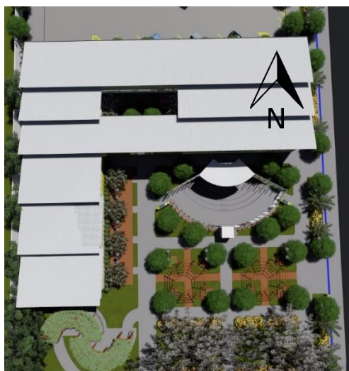
Figura 119 - Sistema shed - Biblioteca Pública Municipal de Macapá
