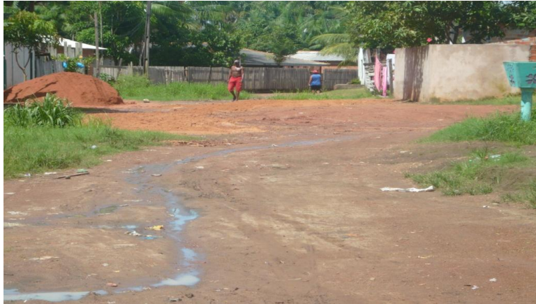
Figura 06: Vias sem Pavimentação. Fonte: Acervo do Grupo
