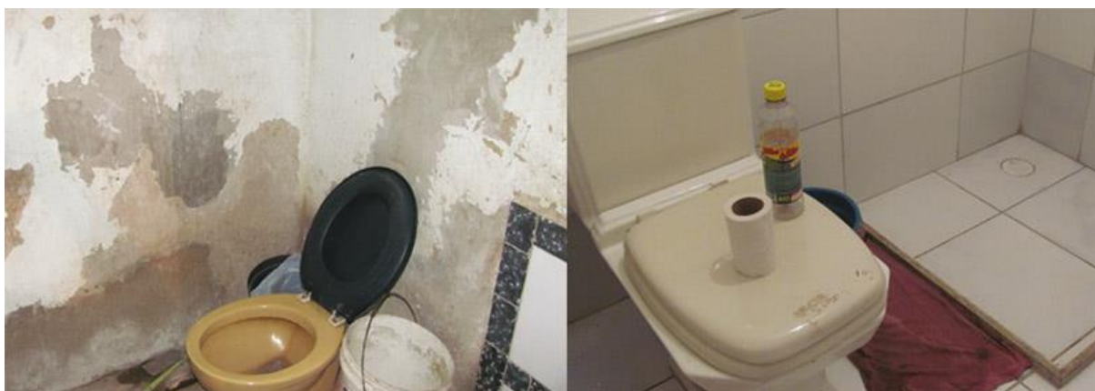
Figura 20 – Antes e depois da reforma
