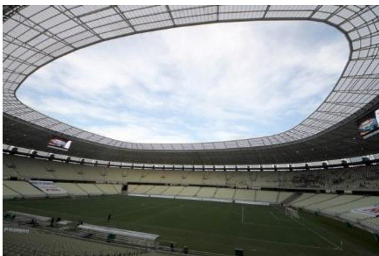
Figura 24: Cobertura reflete os raios solares e proporciona conforto térmico
