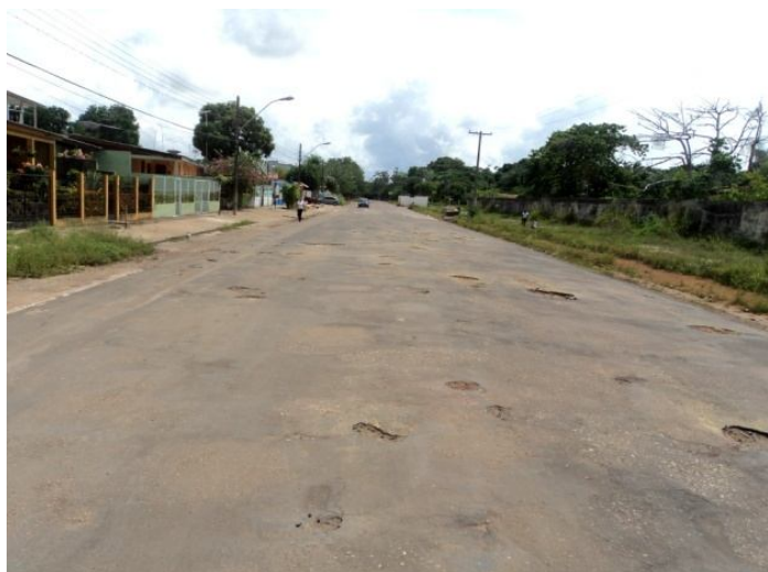
Figura 06: Infraestrutura de pavimentação atual do bairro. Foto: Os autores, 2010.
