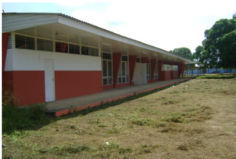
Figura 33: Fachada sul do prédio do Clube Social. Foto: Os autores, 2011.
