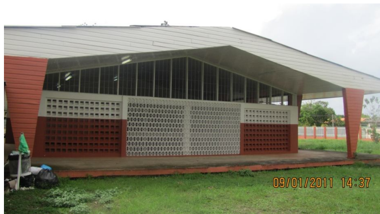
Figura 32: Fachada leste do prédio do Clube Social. Foto: Os autores, 2011.
