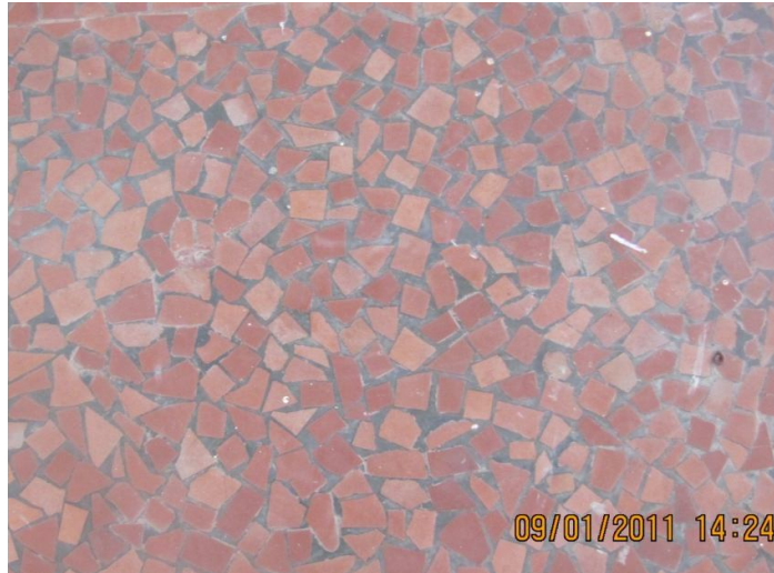
Figura 26: Imagem do piso de Mosaico Cerâmico, predominante na maior parte das edificações do Centro Cívico. Foto: Os autores, 2011.
