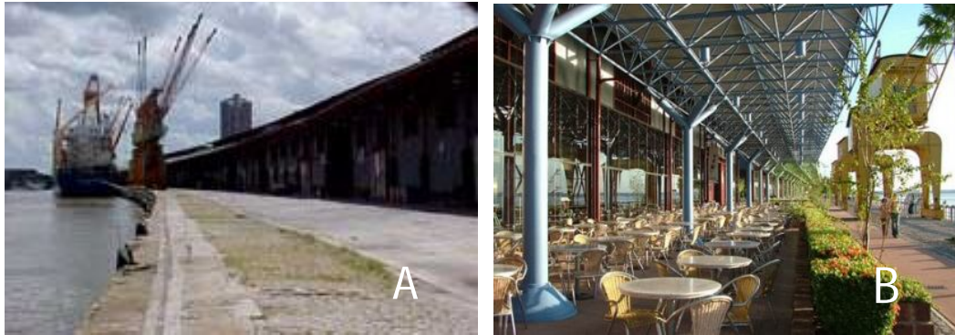
Figura 38: A e B– Imagens dos Armazéns da frente da cidade de Belém - PA, antes e depois da execução do projeto Estação das Docas.
