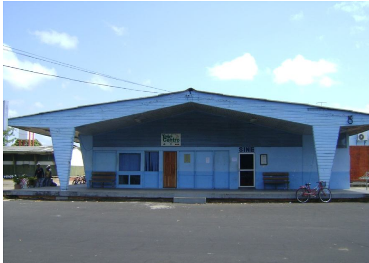
Figura 30: Fachada sul do prédio do Supermercado. Foto: Os autores, 2010
