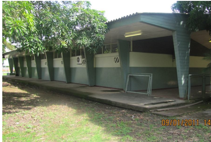
Figura 28: Fachada norte do prédio da Administração de Vilas. Foto: Os autores, 2011.
