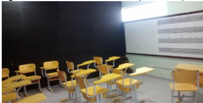
Figura 10 – Sala com revestimento adaptado em espuma
