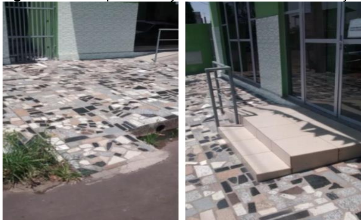
Figura 11 – Rampas da calçada e da entrada da edificação
