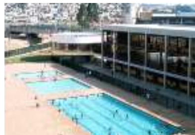
Centro Educacional Unificado (CEU) de Guaianases no estado de São Paulo http://www.arcoweb.com.br
