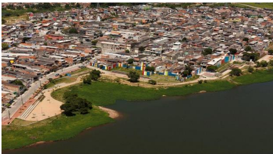
Figura 17: Imagens aéreas da comunidade Cantinho do Céu
