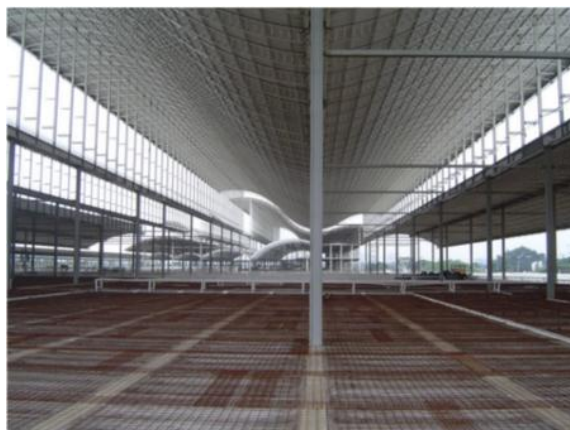
Figura 2.7: Modulação na estrutura metálica da cobertura e pilares.
