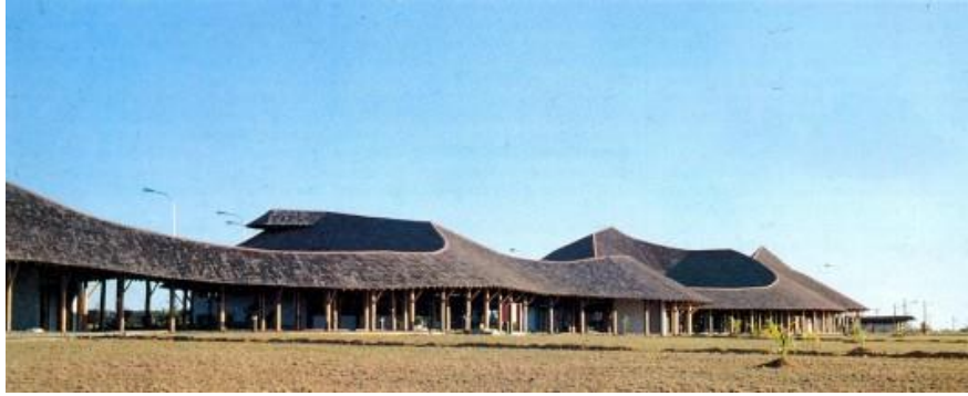
Figura 2.11: Cobertura serpenteante em taubilhas de cavaco.
