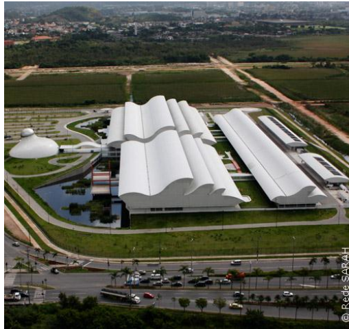
Figura 2.4: Vista aérea do hospital Sarah – Rio de Janeiro.
