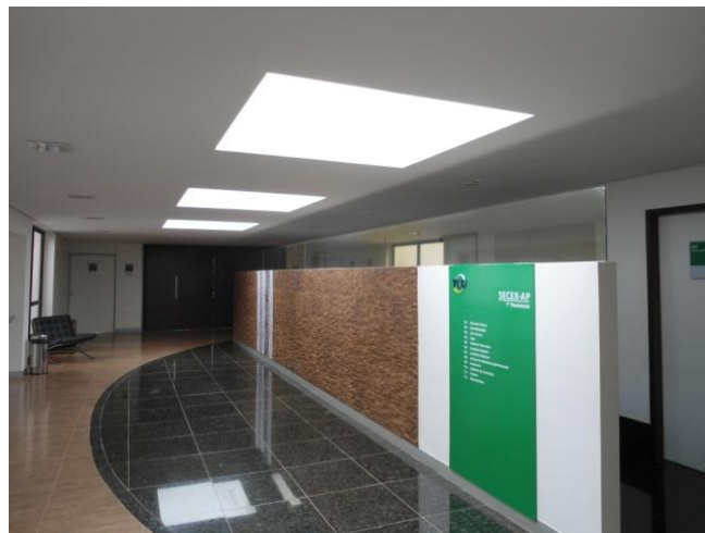
Figura 4.12: Vista interna das claraboias.
