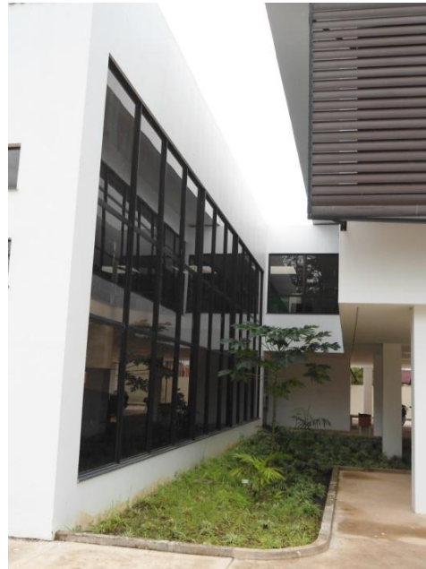
Figura 4.9: Painéis de vidros fixos da escada.
