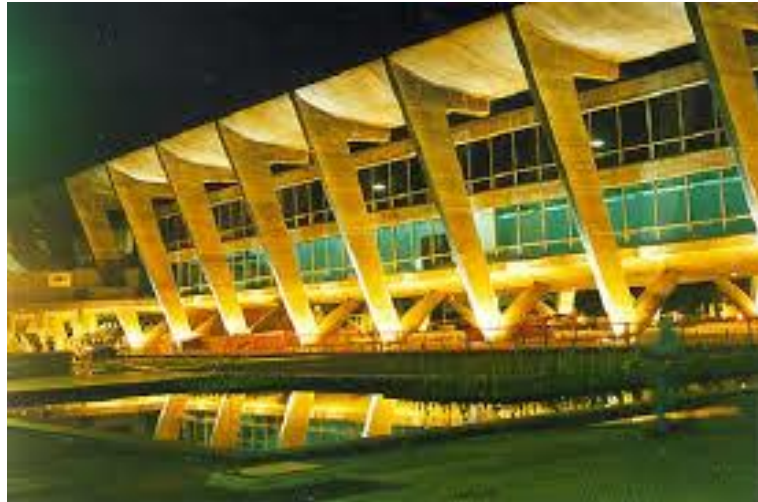
Figura 13 – Museu de Arte Moderna do Rio de Janeiro, projeto de Affonso Reidy. Fonte: disponível no endereço eletrônico https://encrypted-tbn1.gstatic.com/images?q=tbn:ANd9GcS-oIiBoV_VCT8zHk_KJft5a6CcJ8pBE_FpTPOmz7h62lomOX0Vg .
