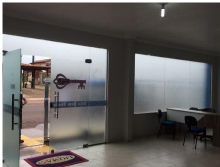
Figura 34 – Aberturas da recepção em vidro pontilhado, fachada sul.
