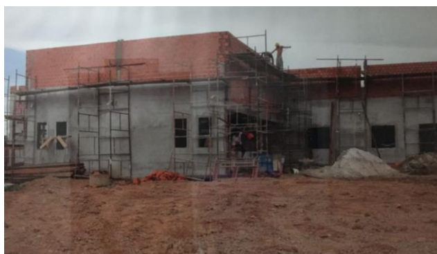
Figura 32 – Materiais construtivos do IJOMA, construção da primeira sede própria, em 2010
