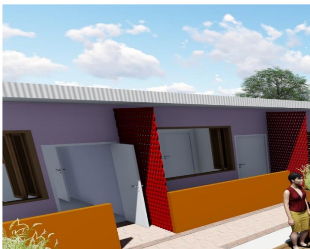
Figura 96 – Beiral e elementos vazados nas aberturas dos quartos
