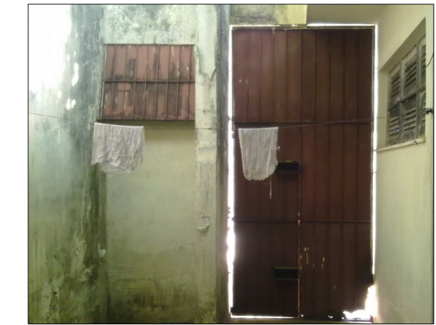
FIGURA : Área de serviço
