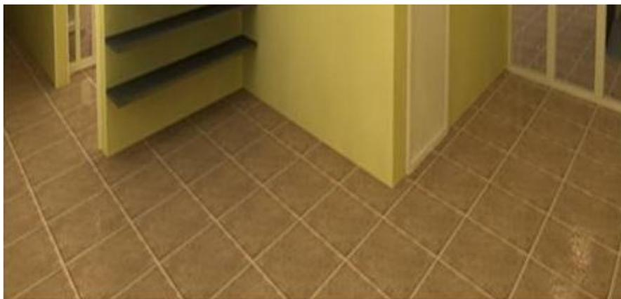
Figura 27: Piso em lajota cerâmica.
