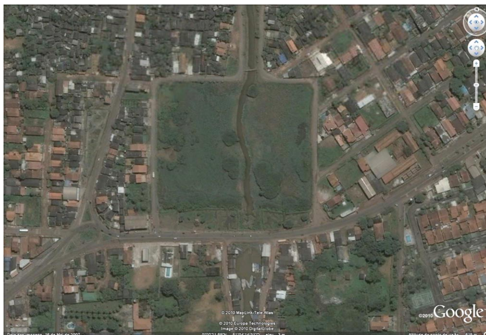
Figura 08: Bacia de Acumulação do Igarapé das Pedrinhas – Vista de topo
