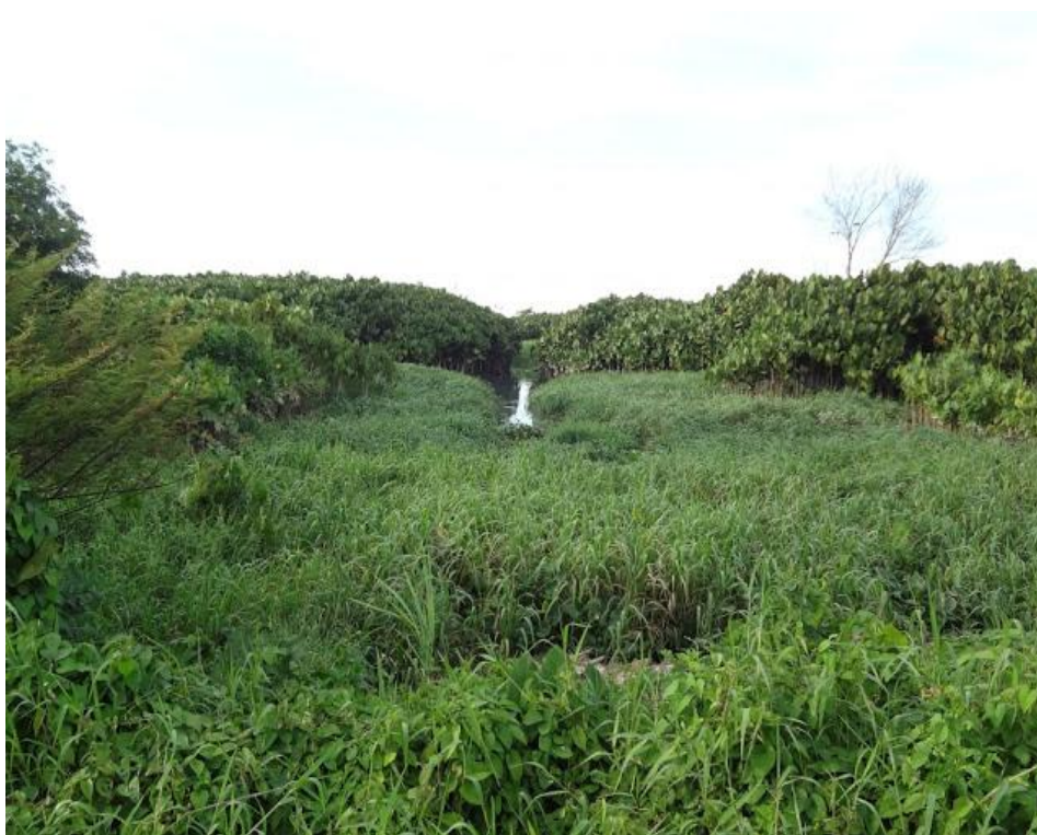
Figura 11: Vista interna da Bacia de Acumulação
