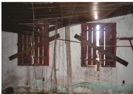
DESCRIÇÃO: Manchas de humidade; presença de cupins no forro de madeira, apodrecimento da madeira de janelas, forro e porta devido a umidade, buracos de descontinuidade na base da parede, presença de vegetação no forro;
