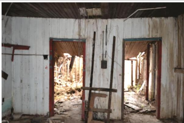
DESCRIÇÃO: Manchas de humidade; presença de cupins no forro de madeira, apodrecimento da madeira de janelas, forro e porta devido a umidade, buracos de descontinuidade na base da parede, presença de vegetação no forro;
