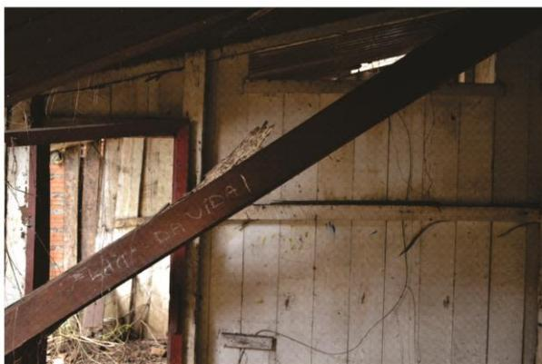
DESCRIÇÃO: presença de vegetação no forro; fissuras na parede; presença de galerias de cupim de terra;
