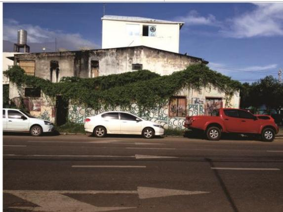
DESCRIÇÃO: DESCRIÇÃO: Fachada oeste da edificação com falta de esquadrias, pichações e presença de vegetação espontânea, descascamento da pintura manchas escuras na parede externa;
