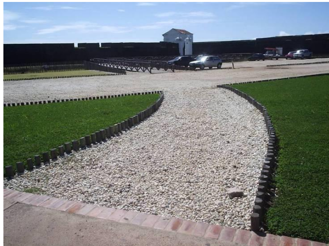
Figura 8: calçamento de pedras impossibilitando o acesso de todas as pessoas ao monumento. Fonte: Bruna Laurindo, Israel Serique, 2010.
