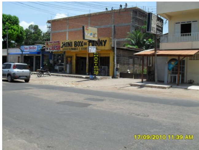
Figura 7: diversos desníveis no passeio público impossibilitando a acessibilidade garantida na NBR 9050. Fonte: Bruna Laurindo, Israel Serique, 2010.
