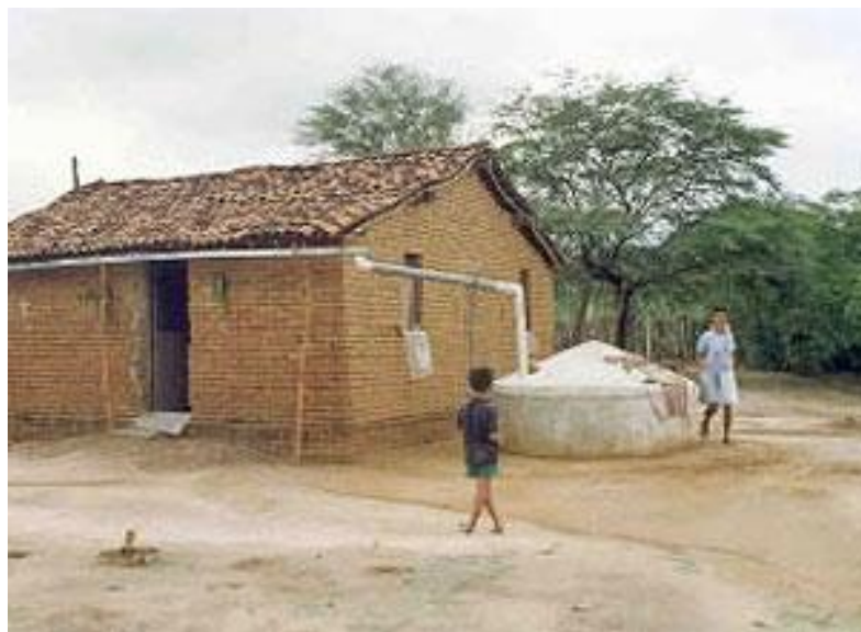
Figura 3: Aproveitamento de água de chuva em cisterna.
