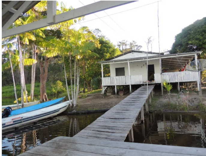
Figura 18: Edificação existente no local.
