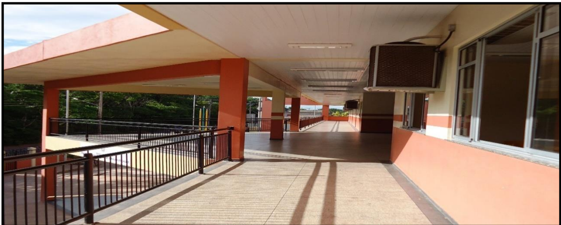
Figura 4.6 – Vista corredor (2º pavimento)
