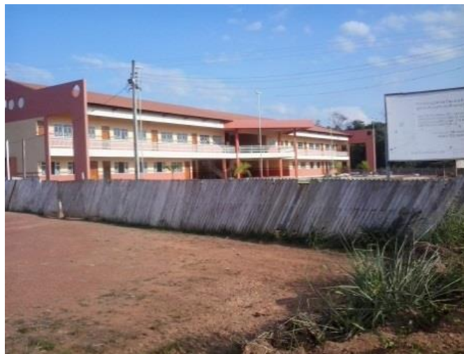
Figura 2.4- Elesbão (STN) – em construção
