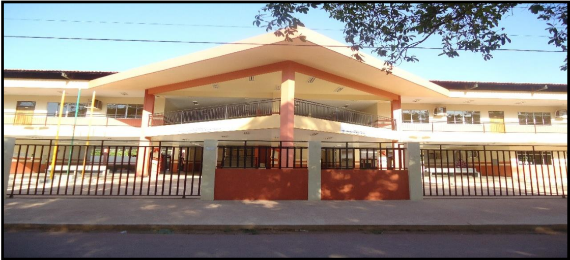
Figura 4.5 – Fachada principal (oeste) da edificação.
