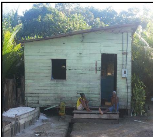
Figura 4.42: Residência do entorno
