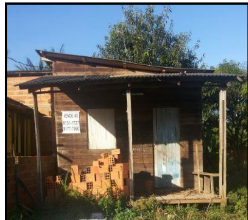
Figura 4.3: Residência do entorno
