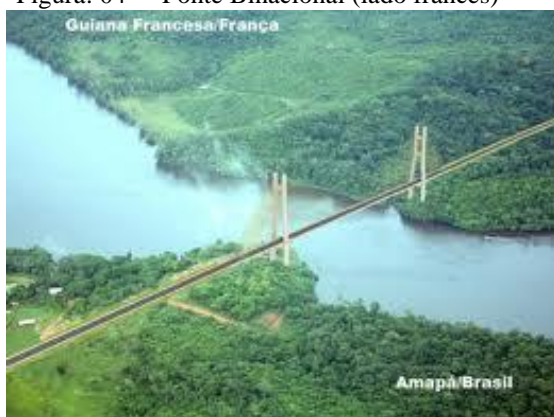
Figura: 04 - Ponte Binacional (lado francês)
