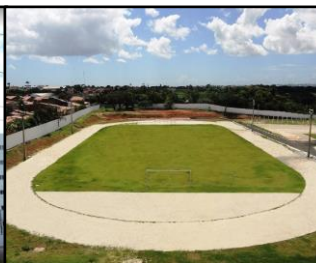
Figura 9: Campo e pista para corrida Fonte: AESP CE (2011)
