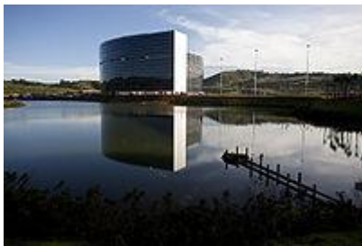
Cidade Administrativa de Minas Gerais
