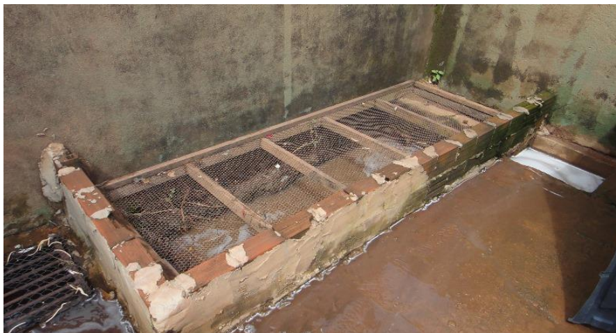
Figura 2 - Sistema de caixa de areia com 3 metros de profundidade utilizada para reter os materiais pesados provenientes da lavagem em determinado lava-jato. Foto: Paula Lopes.
