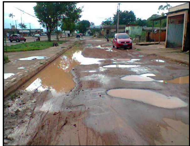
Figura 8: Drenagem no bairro Remédios II
