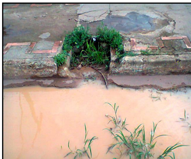
Figura 17: Drenagem do bairro Remédios II
