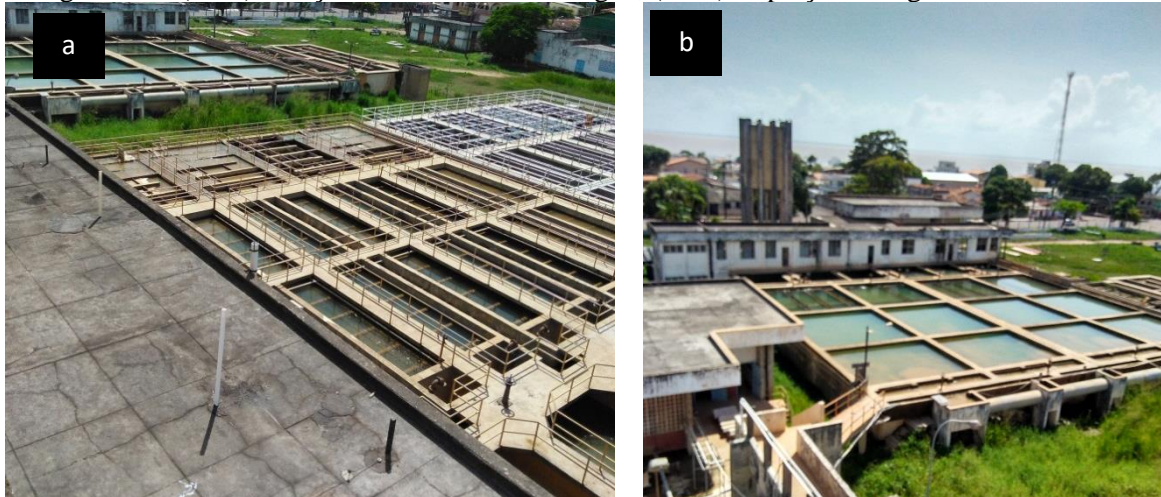
Fotografia 1 – (a e b) Estação de Tratamento de Água; (c e d) Captação de Água
