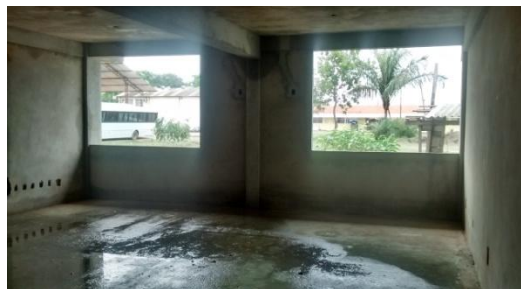
Figura 5 - Vista interna de sala de aula no pavimento térreo
