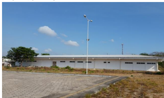
Figura 3 - Vista lateral do prédio destinado à Farmácia Escola.
