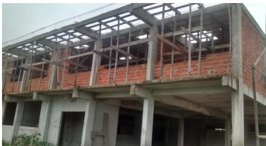
Figura 4 - Vista do pavimento superior com alvenaria quase concluída e vigotas da laje superior instaladas
