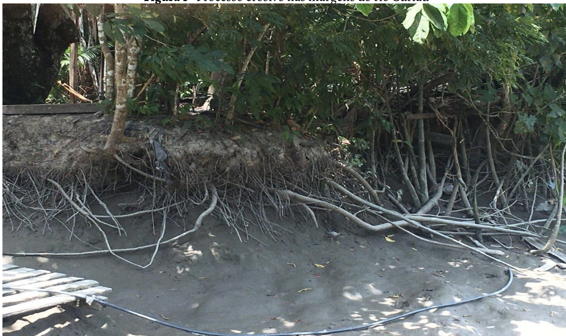
Figura 6 - Processo erosivo nas margens do rio Curiaú
