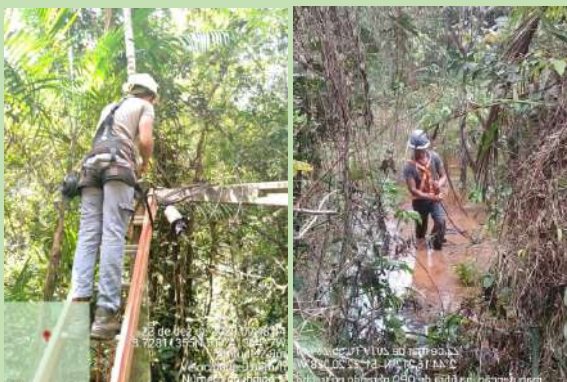
Serviço de Manutenção da Fibra Ótica- OI Fonte: Itamir dos Reis Oliveira -23/12/2020
