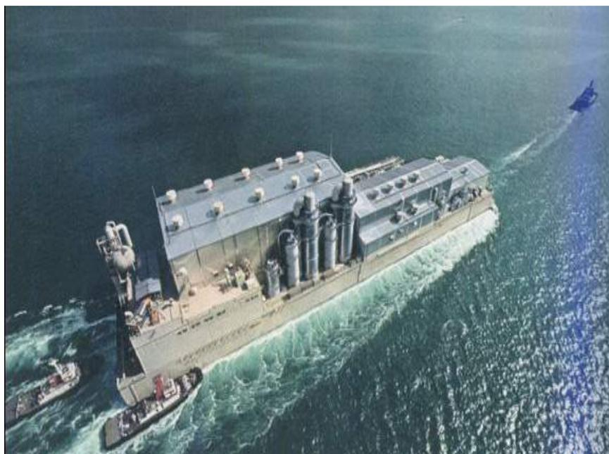
Figura 2 - Fábrica de Celulose do Projeto Jari sendo transportada por rebocadores até o porto de Munguba, Monte Dourado – PA. Fonte: [www.vitruvius.com.br](http://www.vitruvius.com.br)
