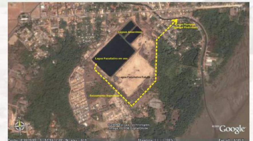
Estação de Tratamento de Esgoto no Bairro das Pedrinhas
