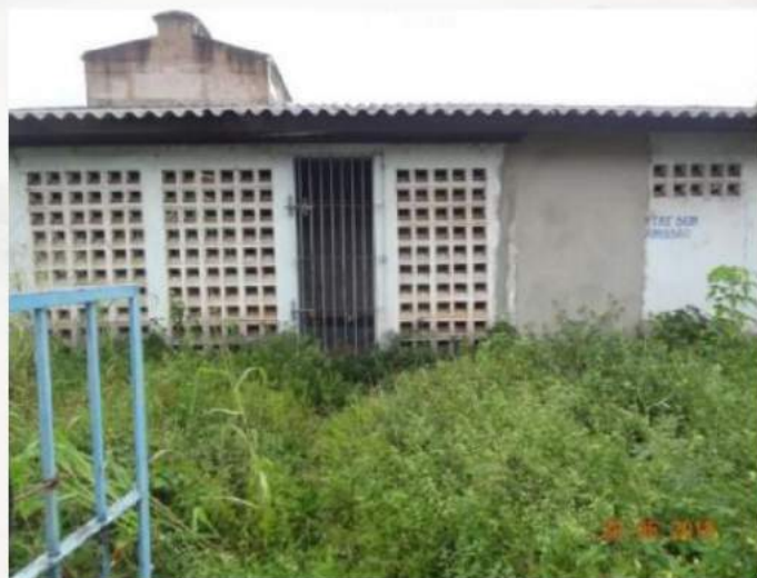
Estação Elevatória de Esgoto na Rua Jovino Dinoá
