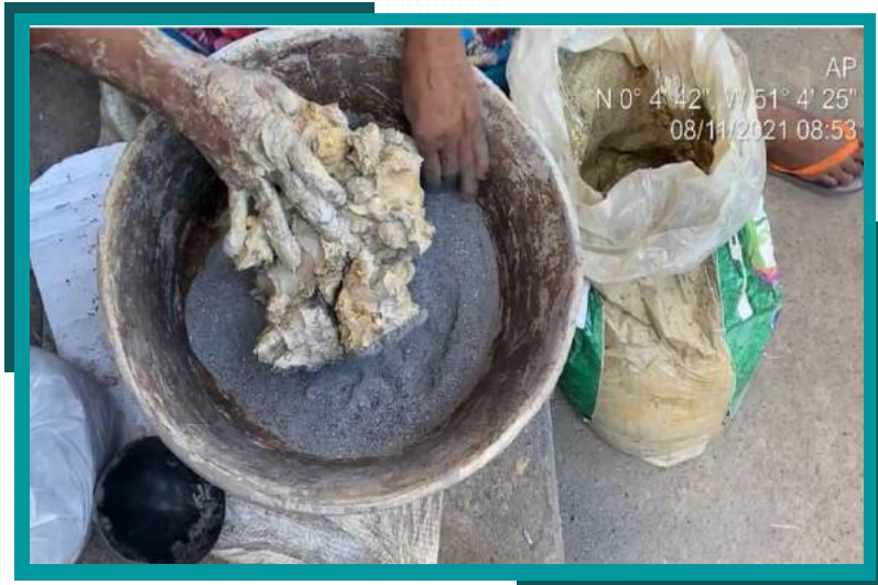
Fotografia 34 - Início da mistura da argila limpa com caripé processado.
