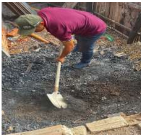
josiel retirando terra
