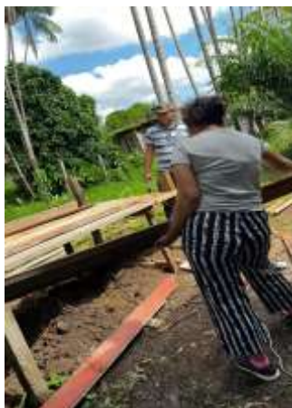
Construindo o canteiro
